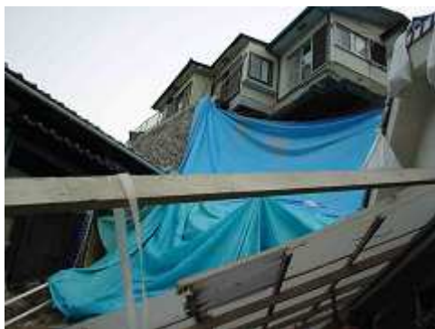
写真1 呉市のガケ地被害
